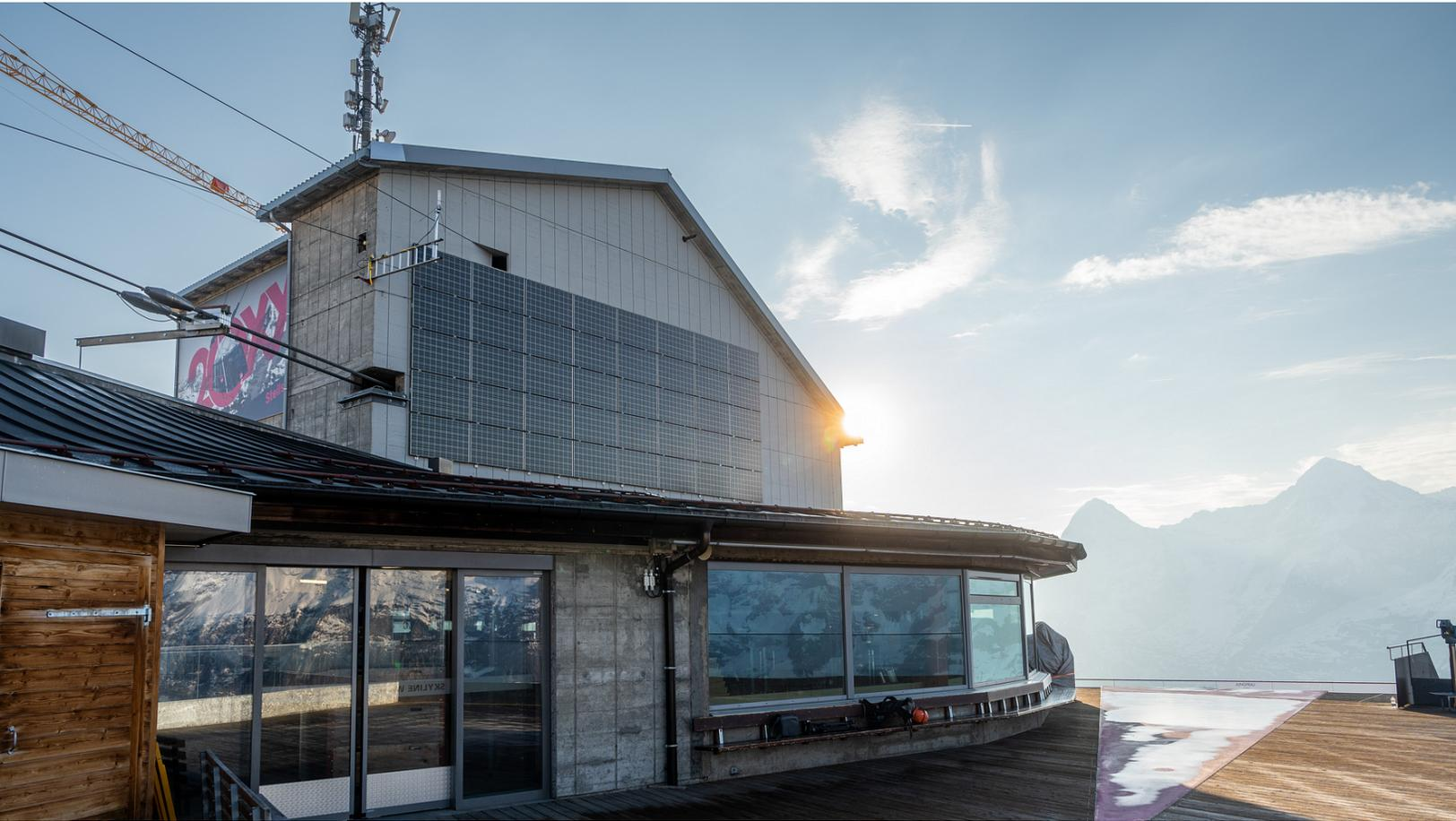
Die ummontierte Photovoltaik-Anlage an der Südfassade der Station Birg liefert effizient wertvollen Strom
